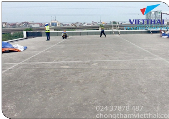
Chuẩn bị bề mặt
