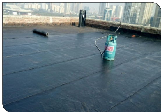
Bề mặt hoàn thiện
