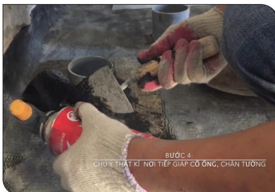
Xử lý cổ ống thoát nước
