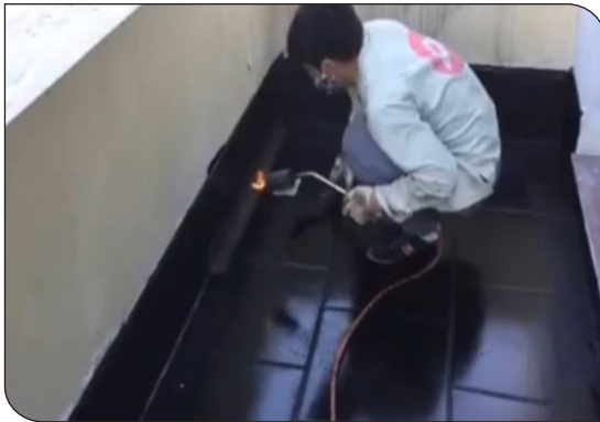
Xử lý góc chân tường
