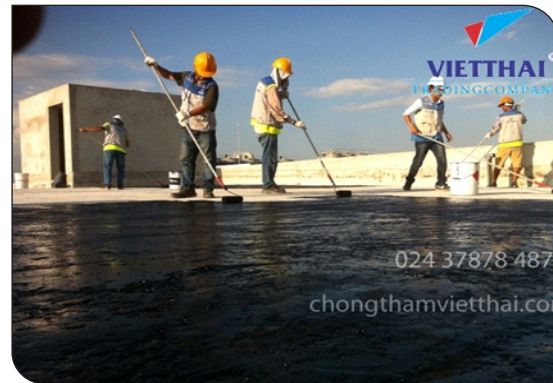
Thi công lăn lớp lót
