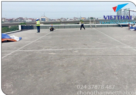
Chuẩn bị bề mặt
