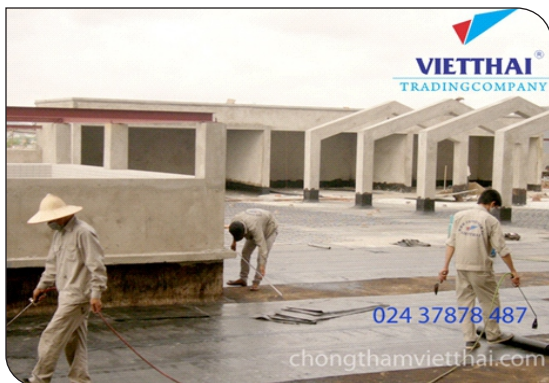
Thi công màng khô nóng
