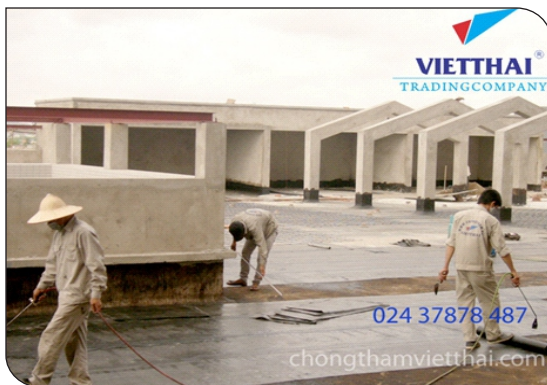
Thi công màng khô nóng
