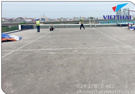
Chuẩn bị bề mặt
