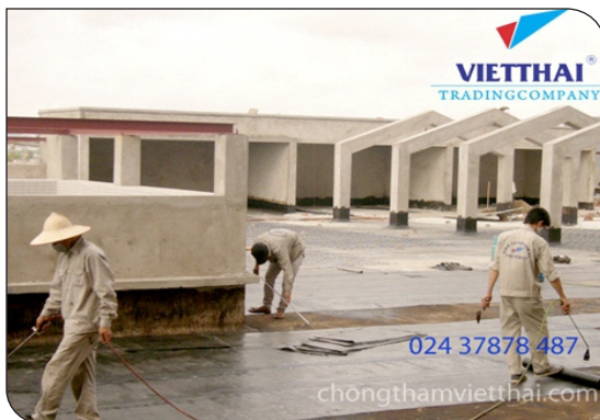
Thi công màng khô nóng
