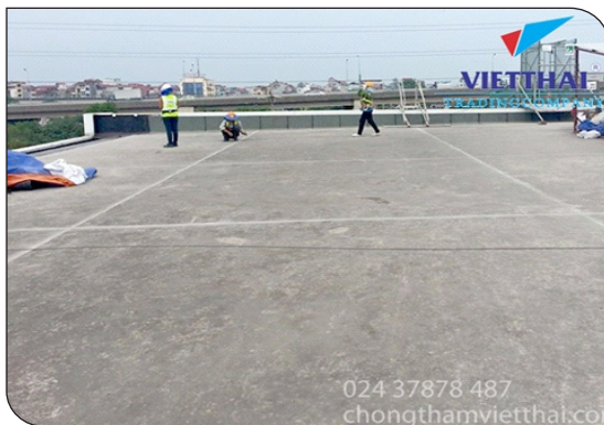
Chuẩn bị bề mặt
