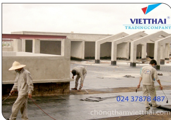
Thi công màng khò nóng
