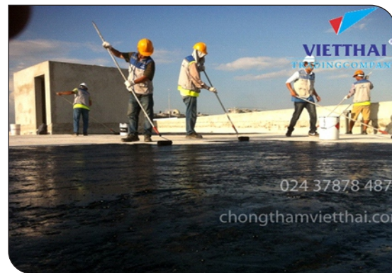
Thi công lăn lớp lót
