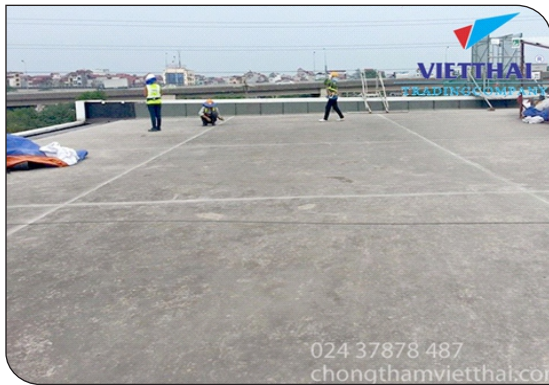
Chuẩn bị bề mặt
