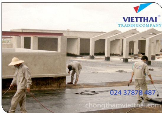
Thi công màng khô nóng
