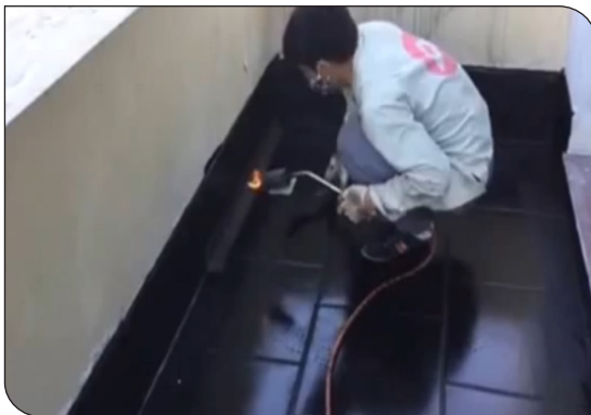
Xử lý góc chân tường
