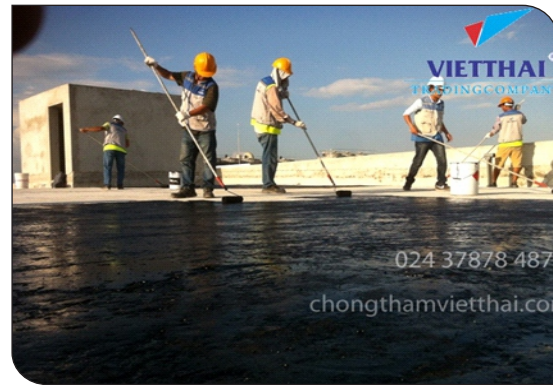
Thi công lăn lớp lót
