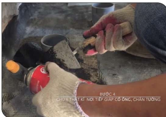
Xử lý cổ ống thoát nước
