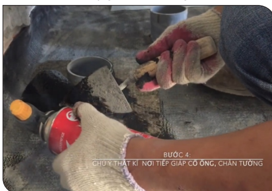
Xử lý cổ ống thoát nước
