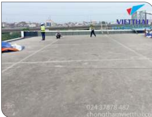
Chuẩn bị bề mặt
