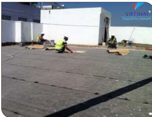
Thi công màng tự dính
