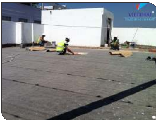
Thi công màng tự dính
