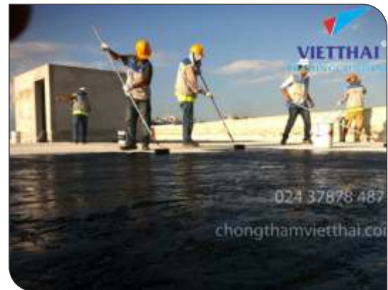
Thi công lăn lớp lót
