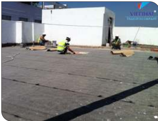
Thi công màng tự dính
