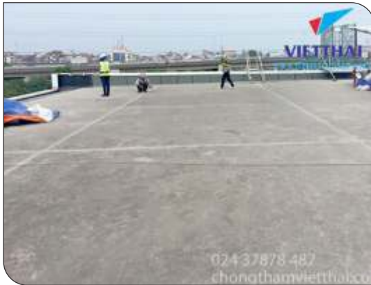
Chuẩn bị bề mặt
