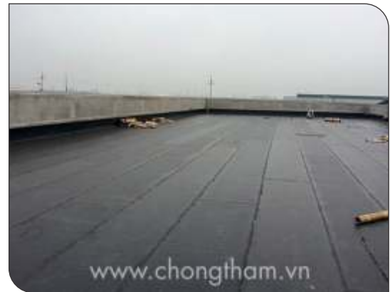
Bề mặt hoàn thiện
