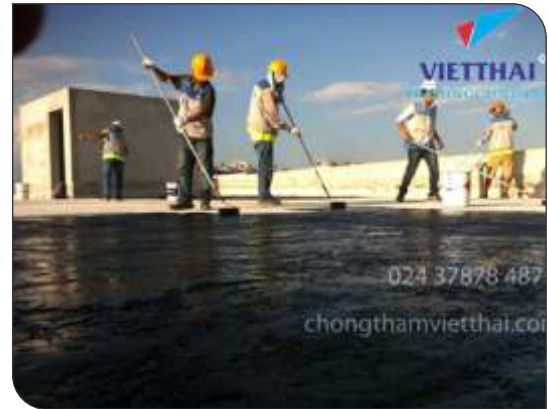
Thi công lăn lớp lót
