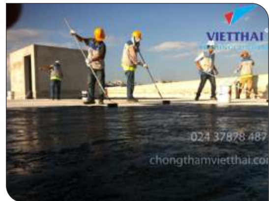
Thi công lăn lớp lót
