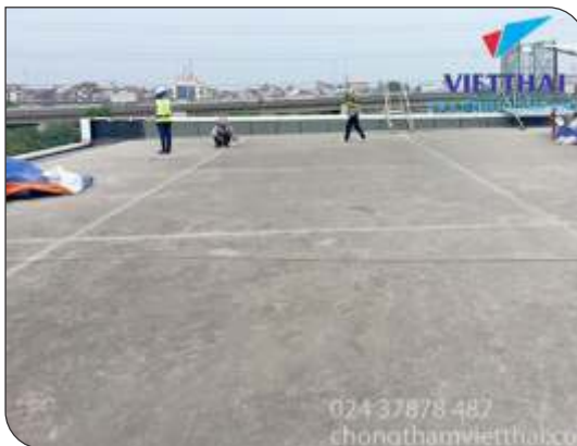
Chuẩn bị bề mặt
