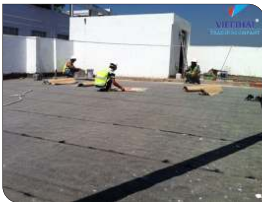
Thi công màng tự dính
