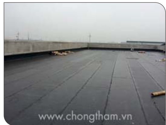
Bề mặt hoàn thiện
