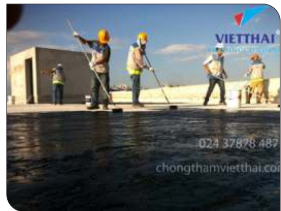
Thi công lăn lớp lót
