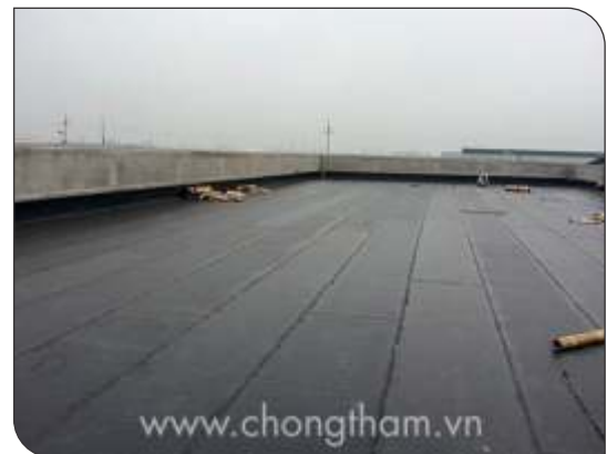
Bề mặt hoàn thiện
