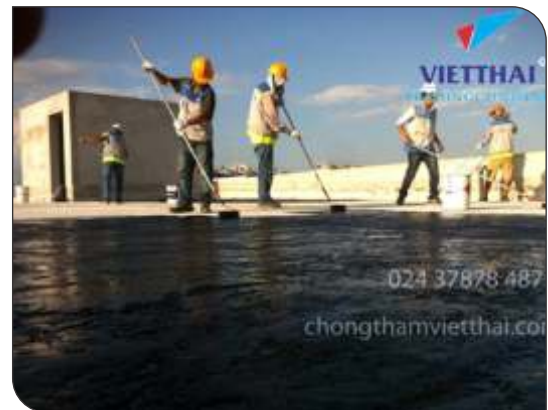
Thi công lăn lớp lót
