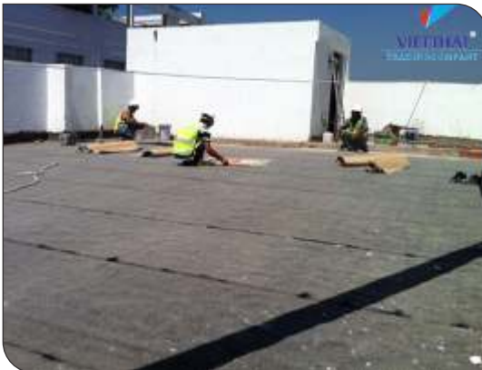
Thi công màng tự dính
