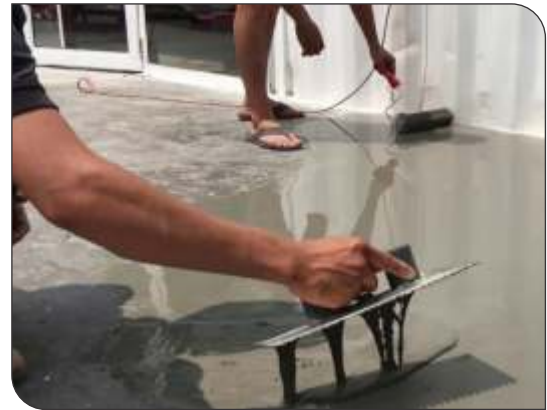
Thi công cán hồ dầu
