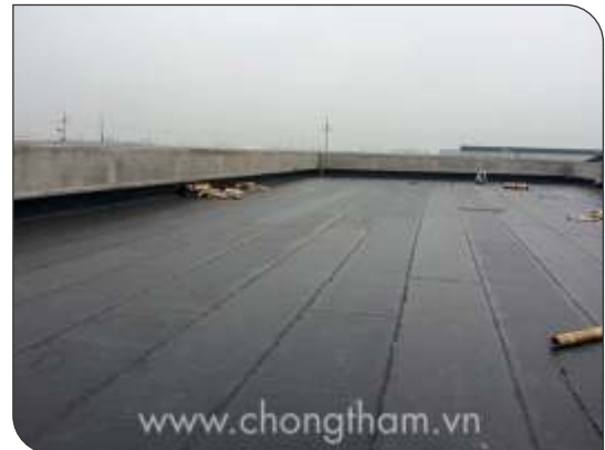
Bề mặt hoàn thiện
