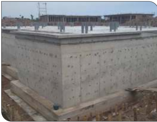
Chuẩn bị bề mặt
