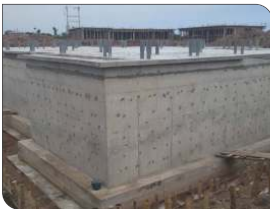
Chuẩn bị bề mặt
