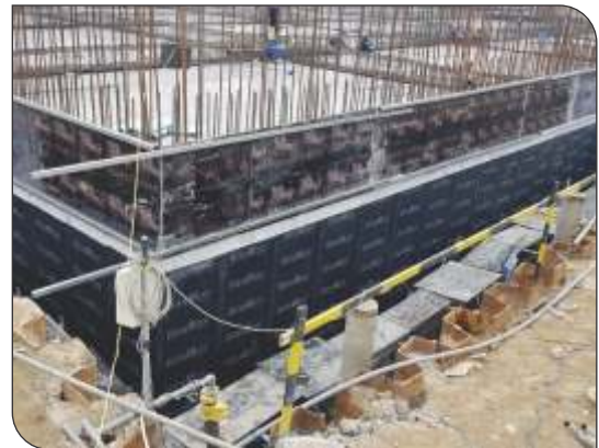
Bề mặt hoàn thiện
