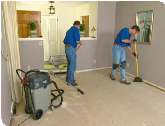
Vệ sinh bề mặt
