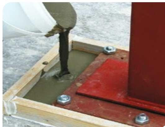
Thi công đổ vữa Grout
