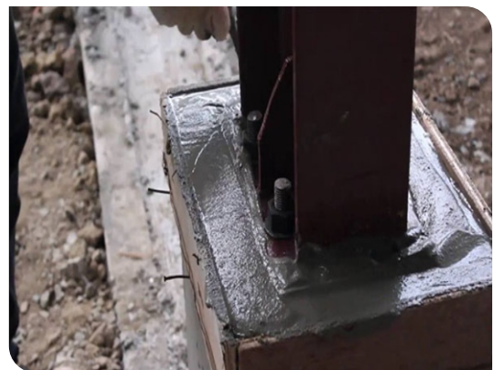
Chân cột sau khi đổ vữa Grout
