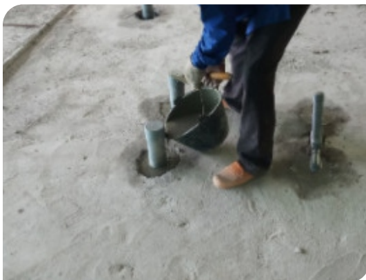
Thi công đổ vữa Grout
