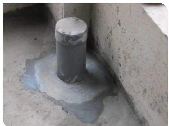
Bề mặt sau khi đổ vữa Grout
